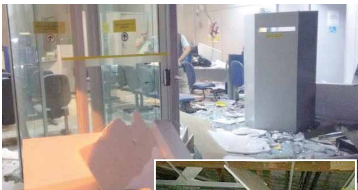
Agências do BB, localizadas no interior da Bahia, serão transformadas em postos de atendimento, em virtude dos ataques a bancos. Como não há investimento em segurança, as ocorrências são recorrentes
