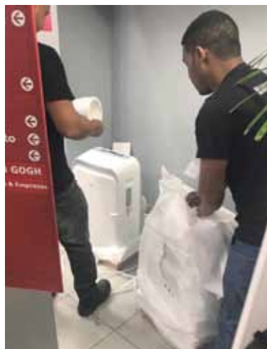
Santander melhora sistema de refrigeração após paralisação do SBBA
