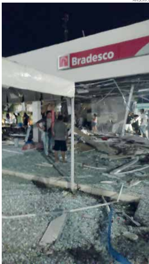
Bradesco de Chorrochó completamente destruído
